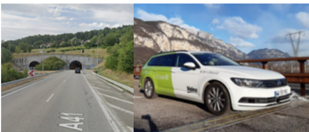
Expérimentation des cas d'usage situation complexe dans un tunnel
